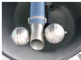
Assèchement du réservoir à boue
